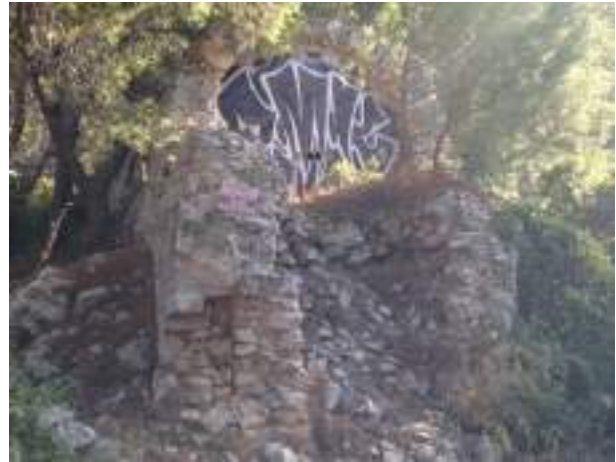
Figure 51 : Cheminée rampante partie sud constituée de deux niveaux
