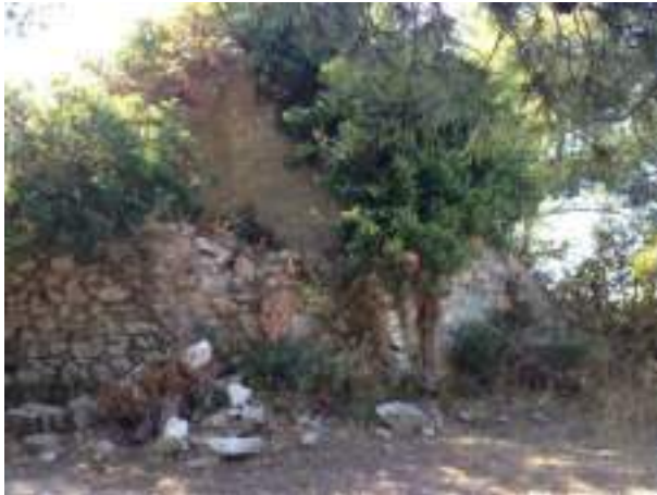
Figure 50 : Cheminée rampante partie nord avec assise en brique
