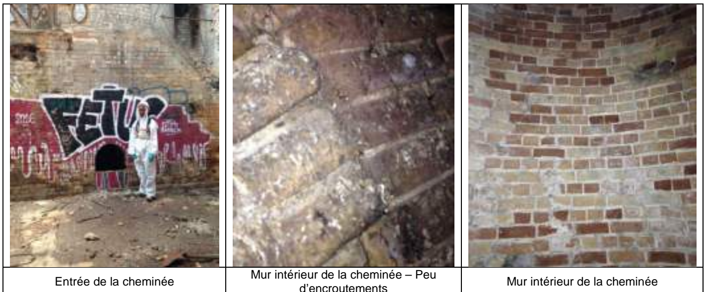
Figure 47: Reportage photographique des investigations réalisées - cheminée verticale sur site
