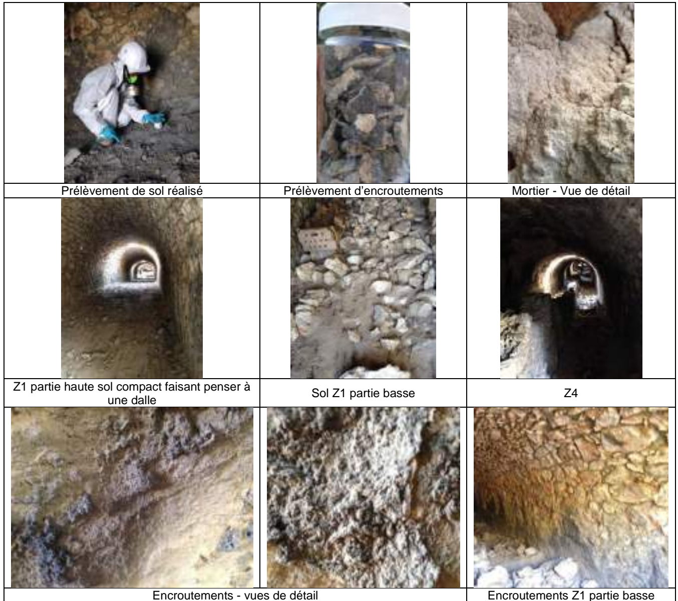
Figure 49: Reportage photographique des investigations réalisées - cheminée rampante
